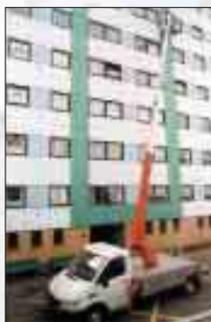
DL21T při opravách fasády v 5. a 6. podlaží. Rychle, bezpečně a s velmi malou plochou záboru.
